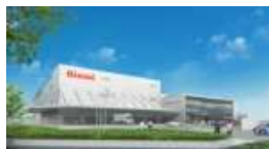
暁工場 新工場棟
